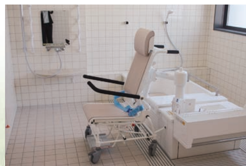
通所介護棟【特殊浴槽】
