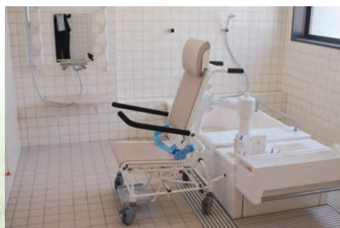
通所介護棟【特殊浴槽】
